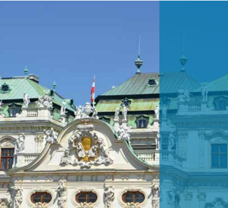
Ein Teil des Daches des Oberen Belvedere wurde zuletzt 2020 mit künstlich patiniertem Kupferblech renoviert. © Bundesdenkmalamt, Foto: Robert Linke
