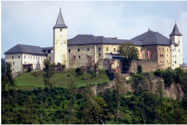
Straßburg, Ansicht der Kernanlage von Süden
