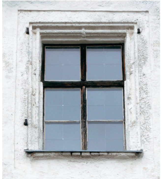
Modulartig vervielfachtes ehemaliges Kreuzstockfenster an der Südfassade des Hohen Stocks. Die Ansätze des zentralen Stein-Kreuzes sind zu erkennen
