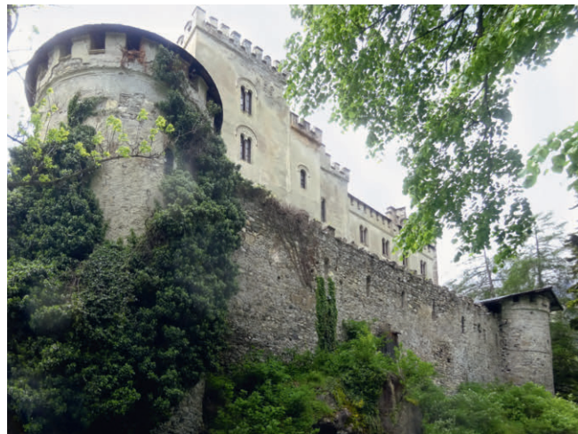
Matrei, spätgotischer Zwinger mit Turmflankierung
