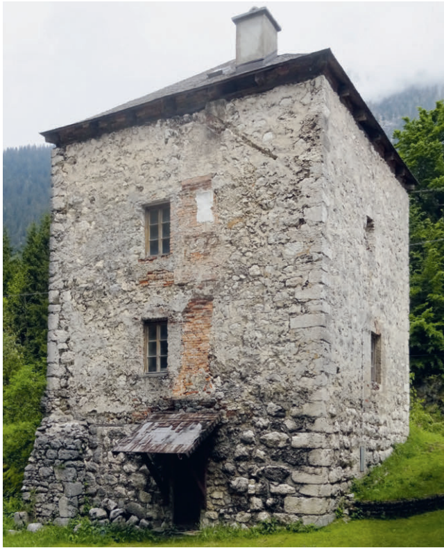
Hallthurm, romanischer Grenzurm mit hausartigem Wiederaufbau der Zeit nach 1382
