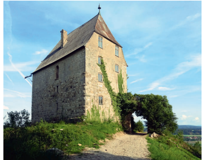
Megling, Ansicht des Festen Hauses von Norden
