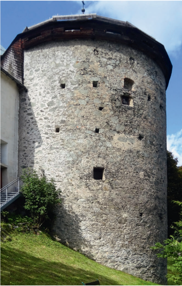
Radstadt, Nordostturm der Stadtbefestigung
