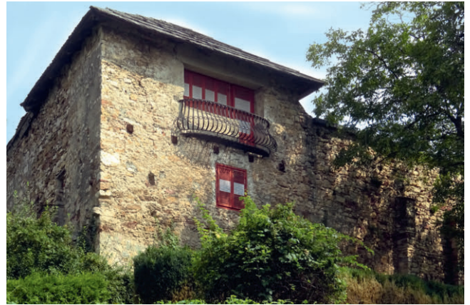
Althofen, Fronfeste, Südwestecke des Kernbaus
