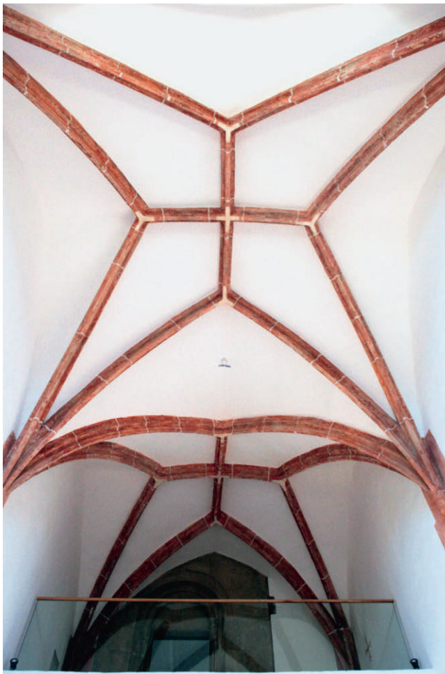
Reichenburg/Rajhenburg, Netzrippengewölbe in der neuen Kapelle
