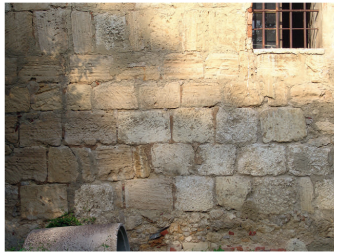
Reichenburg/Rajhenburg, Palas, Mauerwerkstruktur an der Westseite
