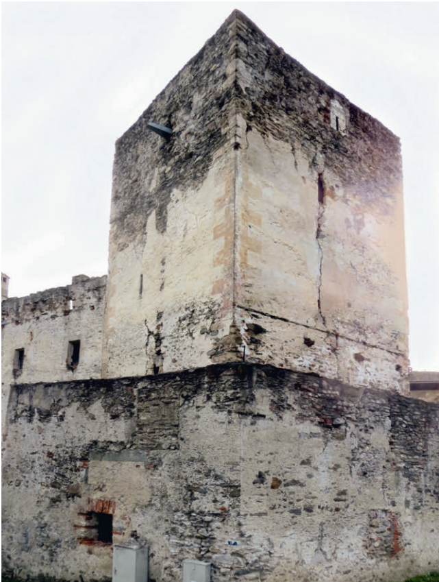
Gmünd, neuer nördlicher Eckturm der Stadtbefestigung
