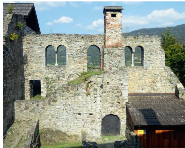
Hofwand des Nordtraktes mit zugehöriger Freitreppe
