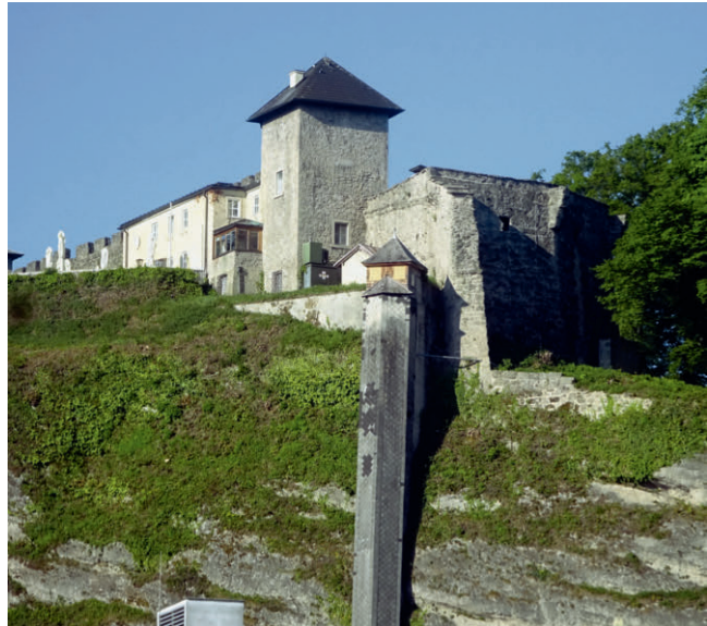
Nordende der Bürgerwehr. An den spätromanischen Eckturm wurde im 14. Jahrhundert eine Erweiterung bis zur Felskante geschoben, davor entstand im 15. Jahrhundert ein Zwinger mit polygonaler Geschützbasistei, die Konsolen gehörten zu einem hölzernen Wehrschirm
