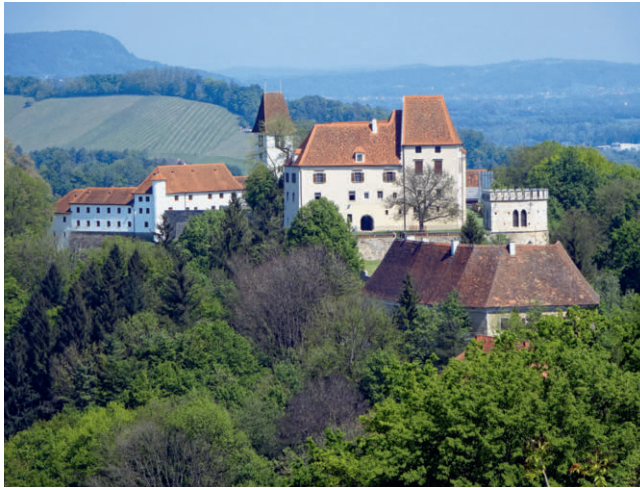
Seggau, Ansicht von Süden. Im Zentrum steht die einstige Kernburg, in deren Mitte einst der große Turm dominierte, nördlich liegt auf einer Hangstufe die Vorburg, südlich (im Vordergrund) entwickelte sich ein Burgmannensitz zur eigenständigen Adelsburg
