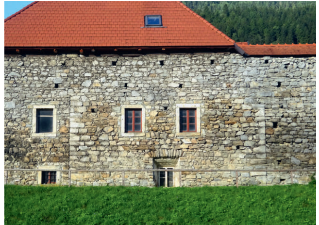
Friesach, überbauter Turm in der Stadtmauer
