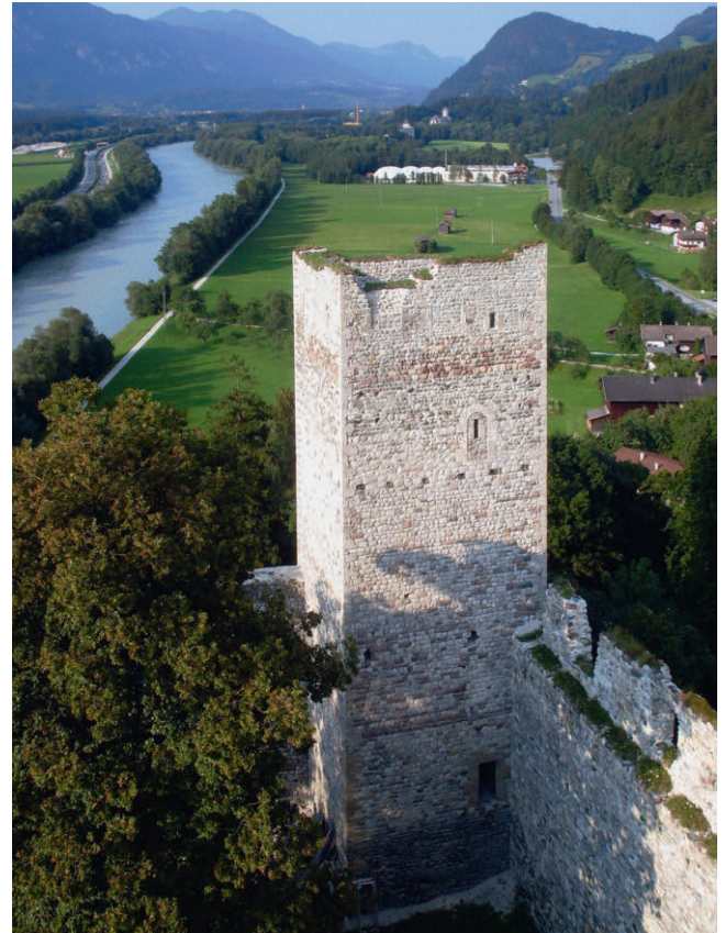
Kropfsberg in Nordtirol, Blick vom Bergfried auf den Ostturm, im Hintergrund das Inntal
