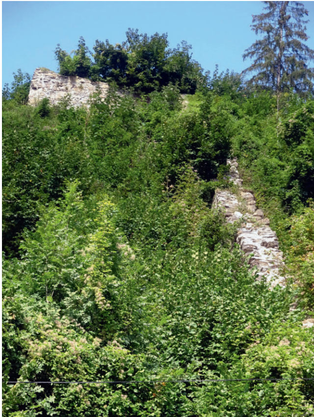
Talsperre am Mandlingpass
