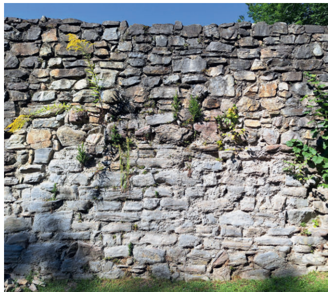
Friesach, Sockelrest der nordwestlichen Stadtmauer im Garten des einstigen Dominikanerklosters
