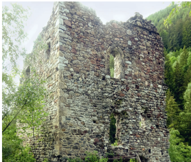
Kienburg in Osttirol, Blick vom Hof auf den Südbau
