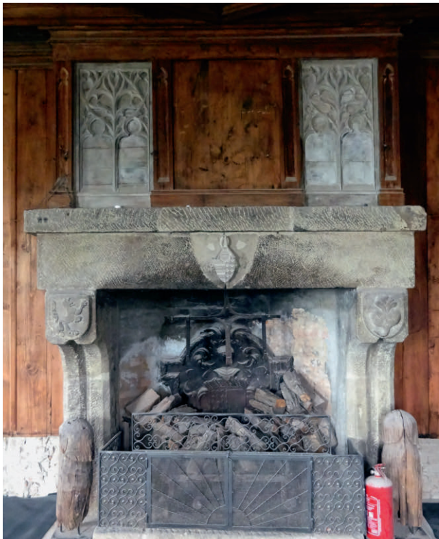
Greifenstein, Kamin im Rittersaal
