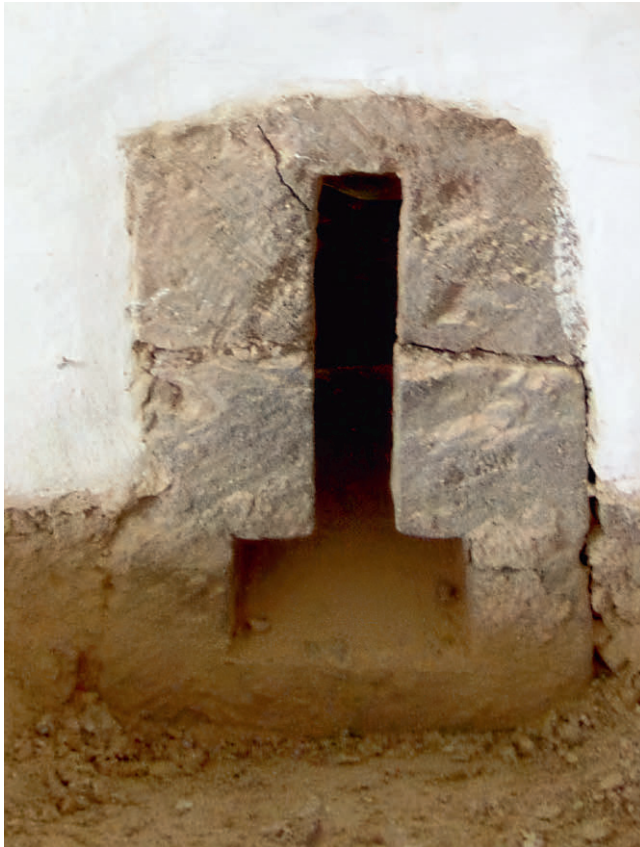
Reichenburg/Rajhenburg, spätgotische Spatenscharte am Kapellenturm
