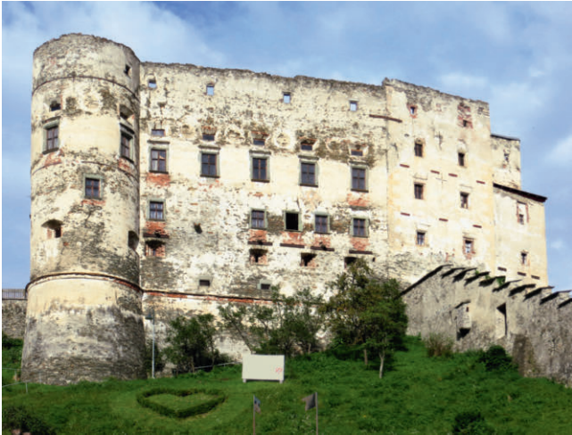
Gmünd, weit vor die Stadtbefestigung geschobene Erweiterung der alten Burg (rechts)
