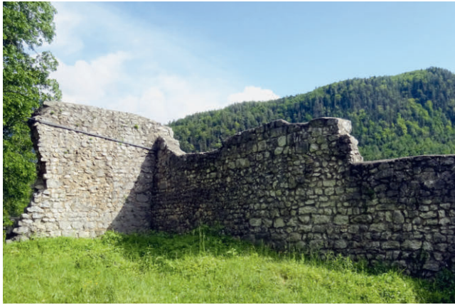
Karlstein, romanischer Bering und Ansatz eines Hofgebäudes
