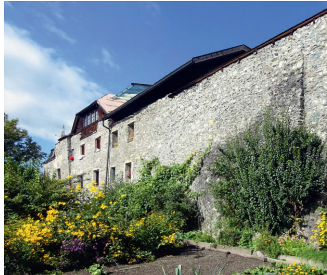
Radstadt, Abschnitt der Südmauer
