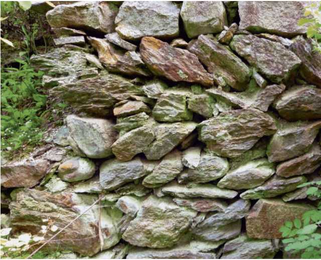
Leobenegg, Detail der Nordwand
