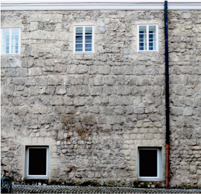
Stadtmauer in der Basteigasse
