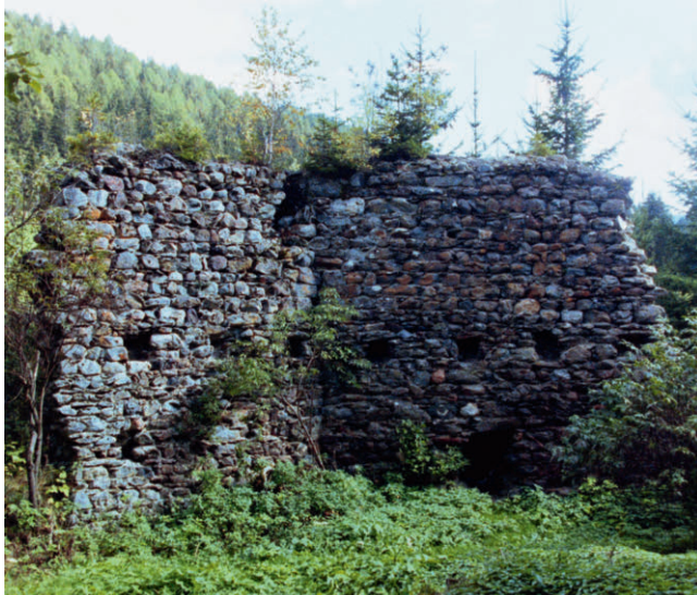
Thurnschall, Detail der dünnen Talseite vor der Restaurierung
