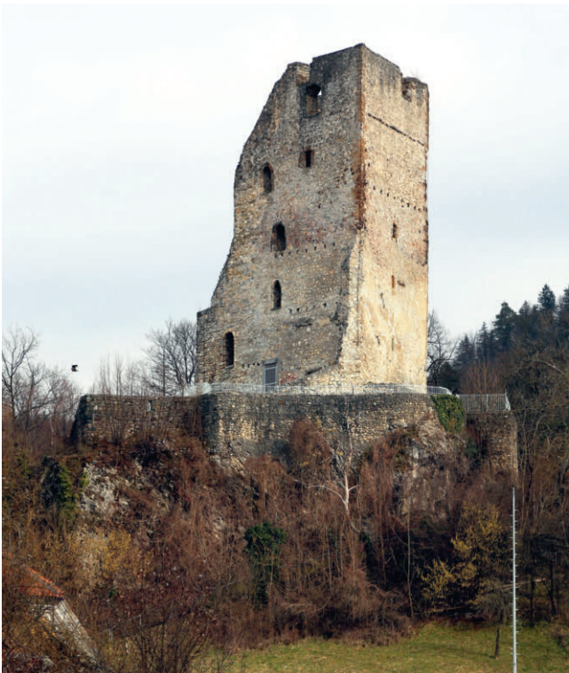
Schalegg/Šalek, Ansicht von Westen
