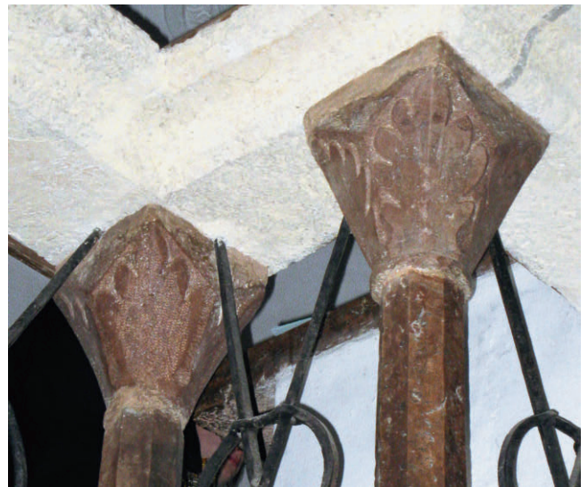
Hohenwerfen, in der Balustrade der Renaissance-Kapelle verbaute ältere Kapitelle
