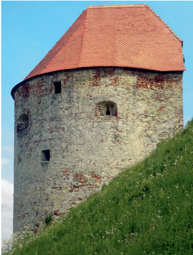
Pettau/Ptuj, spätgotischer Hufeisenturm nördlich der Kernanlage inmitten eines Steilhanges
