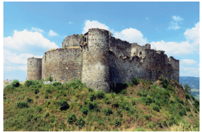
Taggenbrunn, Ostansicht vor der Modernisierung
