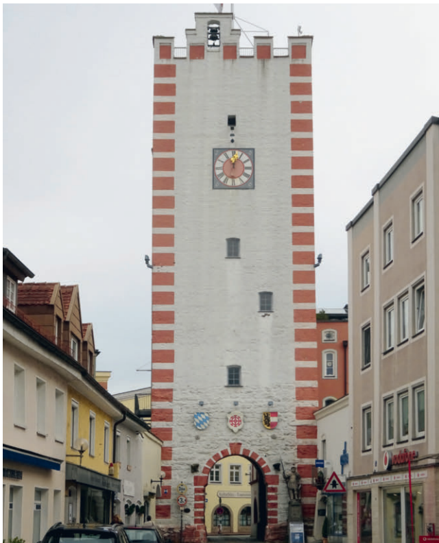
Mühldorf am Inn, später aufgestocktes westliches Stadttor
