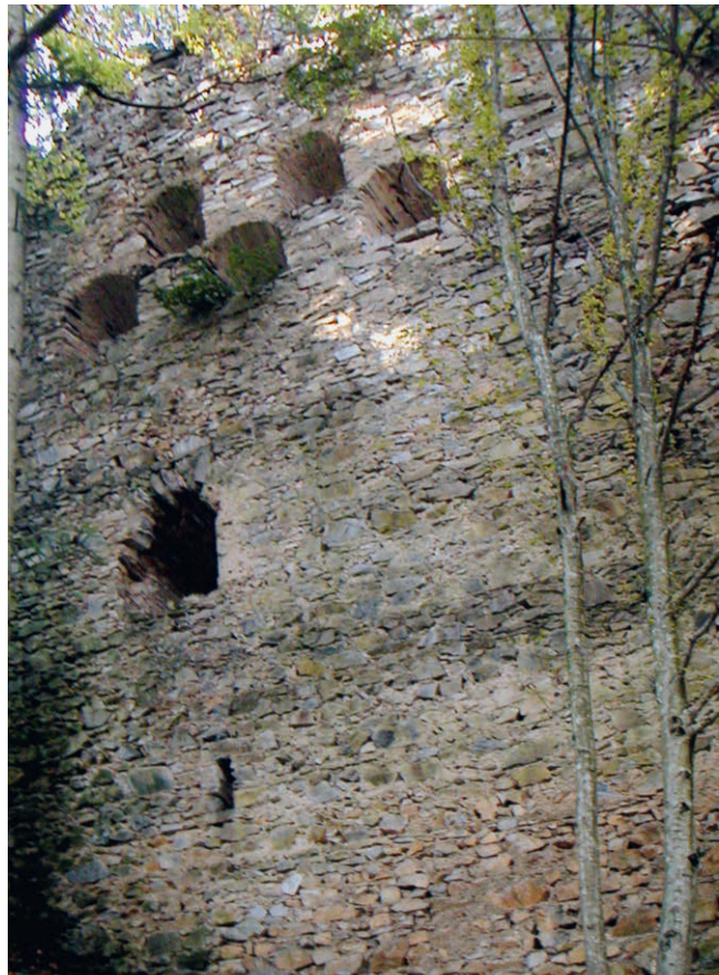
Waxenegg, untere Burg, Blick auf den Wohnturm mit der Fenstergruppe der ehemaligen hölzernen Stube
