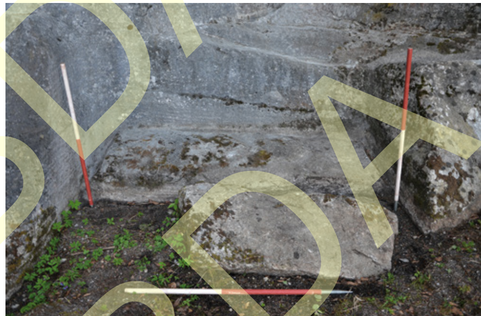
Abb. 71 Spitzelofen. Steinbruch GO 38. Abrissfläche, Schrämispurendetail A 38-6.
