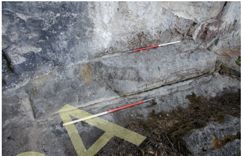
Abb. 70 Spitzelofen. Steinbruch GO 38. Horizontaler Schrotschlitz mit Keilnut, Schrämispurendetail A 38-8.
