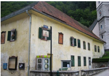
Zustand vor der Restaurierung
