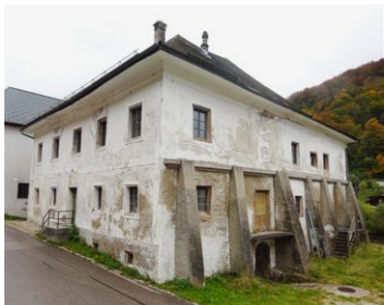
Strebepfeiler an der Nordseite des Gebäudes, vor der Restaurierung
