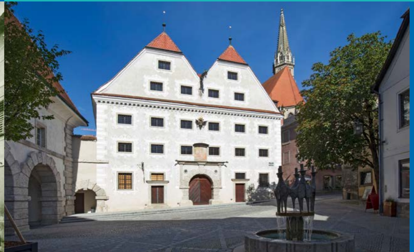
Aufnahme 2020: nach der Restaurierung © Bundesdenkmalamt, Foto: Irene Hofer
