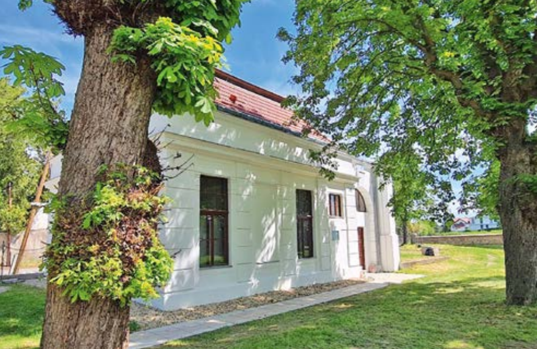
Der erhaltene Teil des Badener Friedhofswärterhauses, das an das zerstörte Taharahaus angeschlossen war, konnte saniert werden. © IKG-Wien, Foto: Tanner
