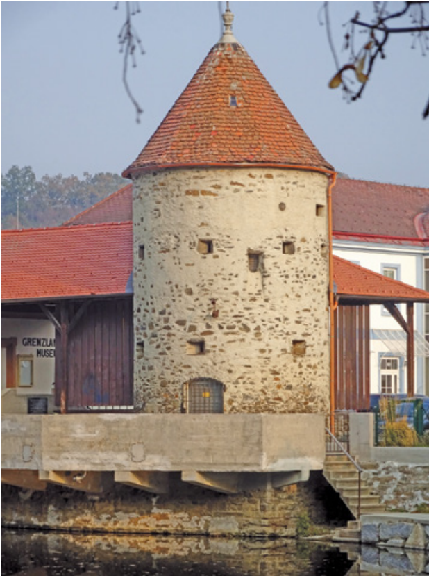
Abb. 19 Raabs an der Thaya, Marktbefestigung. Eckturm.
