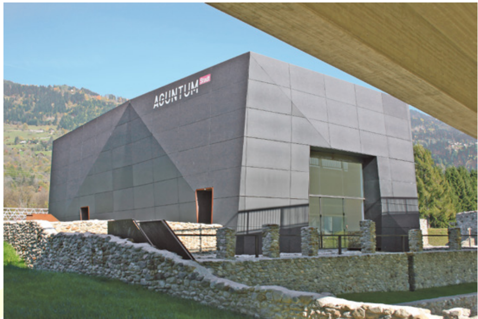
Abb. 1 Dölsach. Schutzhaus über dem Atriumhaus in Aguntum.
