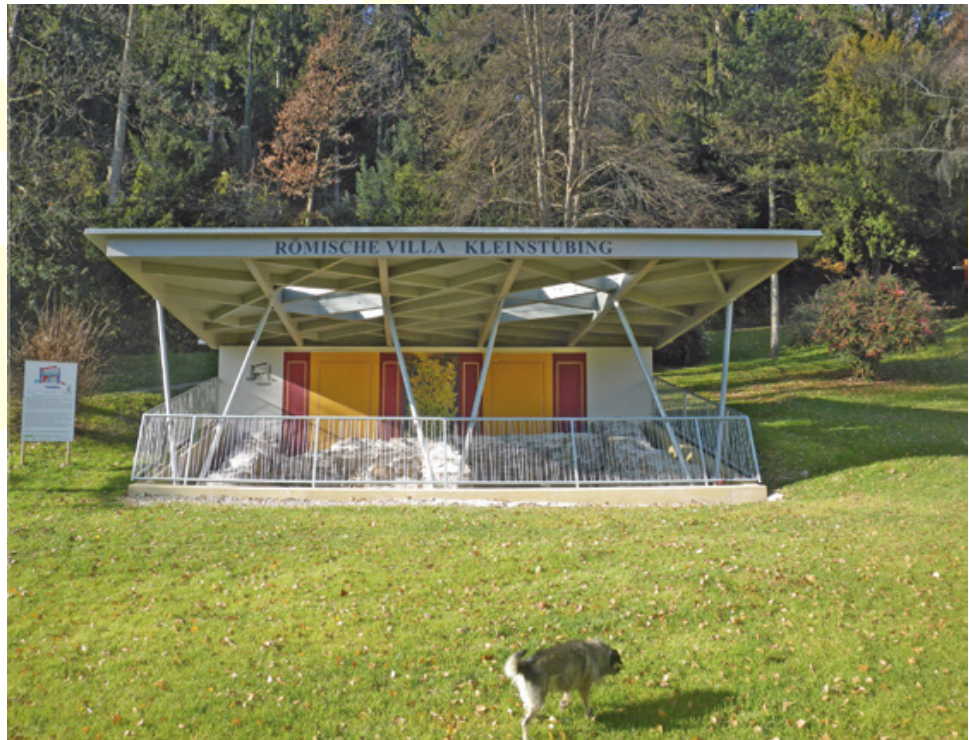
Abb. 2 Kleinstübing. Schutzdach über den Resten der Villa rustica.
