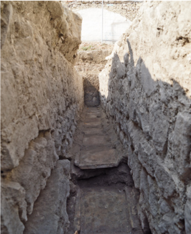
Abb. 7 Müllendorf (Mnr. 30013.20.01). Innenseite des römischen Kanals in Baukomplex I (Blick nach Westen).
