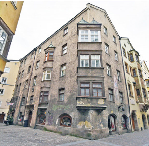
Abb. 4 Innsbruck, Kleines Riesenhaus. Gesamtansicht des Gebäudes (Blick nach Südwesten).
