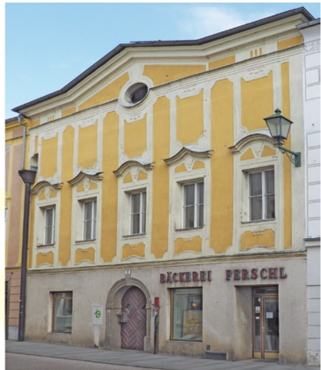
Abb. 3 Freistadt, Bürgerhaus. Fassade.
