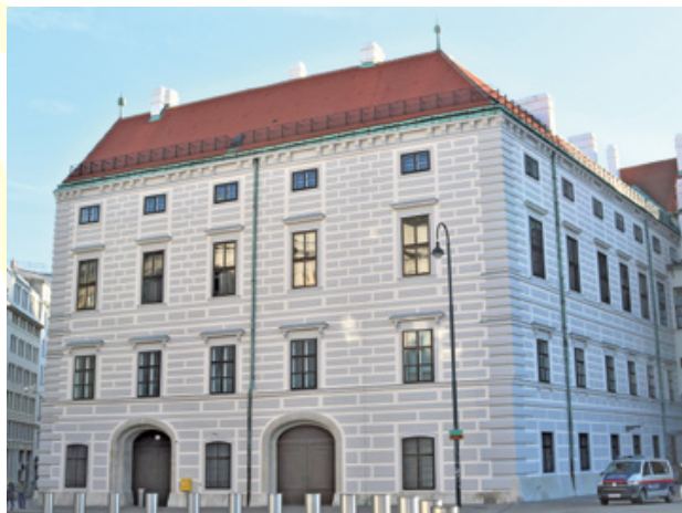
Abb. 1 Innere Stadt, Hofburg. Amalienburg nach der Fassadensanierung 2020 (Ansicht von Westen).
