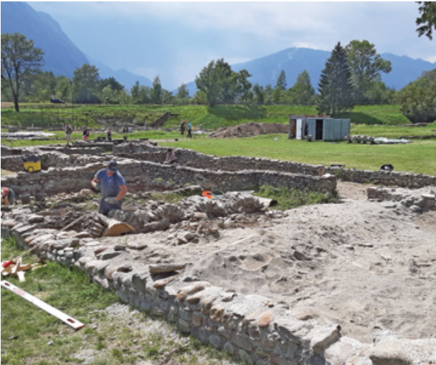
Abb. 15 Dölsach (Tir.). Rekonstruktion von Hypokaustbögen über einer hölzernen Schalung im Handwerkerviertel von Aguntum.
