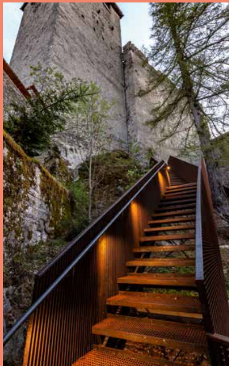
Cortenstahltrappe zur Erschließung der mittelalterlichen Kernburg © Burg Heinfels, Foto: Peter Leiter
