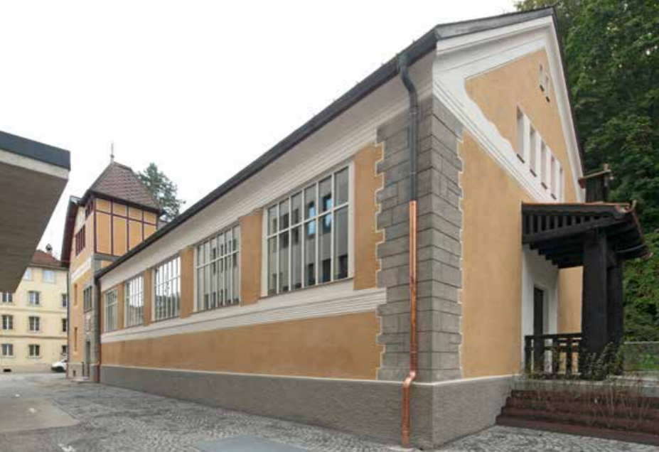
Jahnturnhalle nach der Sanierung 2020 © BDA, Foto: Bettina Neubauer-Pregl
