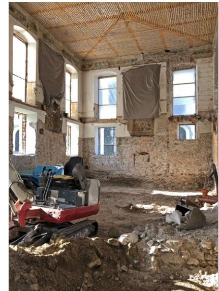
Innenraum nach Abbruch der Einbauten der 1940er Jahre
