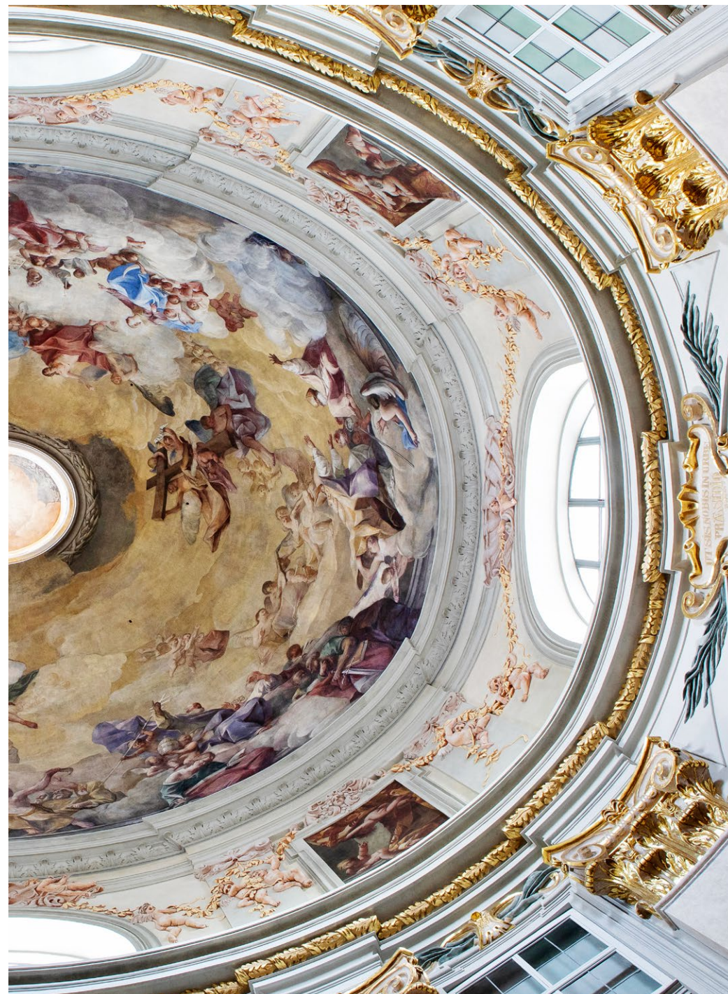
Zustand nach der Restaurierung
