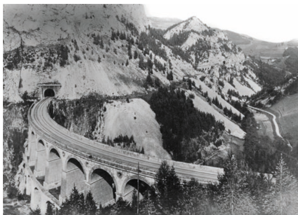
230. Semmeringbahn, Viadukt über die Kalte Rinne, um 1900
