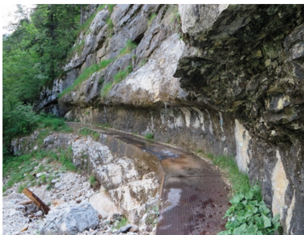
235. Hallstatt, Oberösterreich, Trasse der aus dem Felsen gebrochenen Soleleitung
