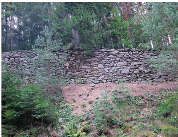
224. Pöggstall, Niederösterreich, Stützmauer der Fürnberg'schen Poststraße
