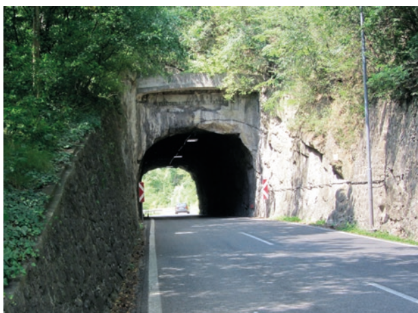
226. Baden, Niederösterreich, Urteilstein-Straßentunnel, 1826/1827
