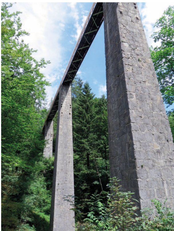
237. Hallstatt, Oberösterreich, Soleleitung, Gosauzwang-Brücke, 1755–1757
