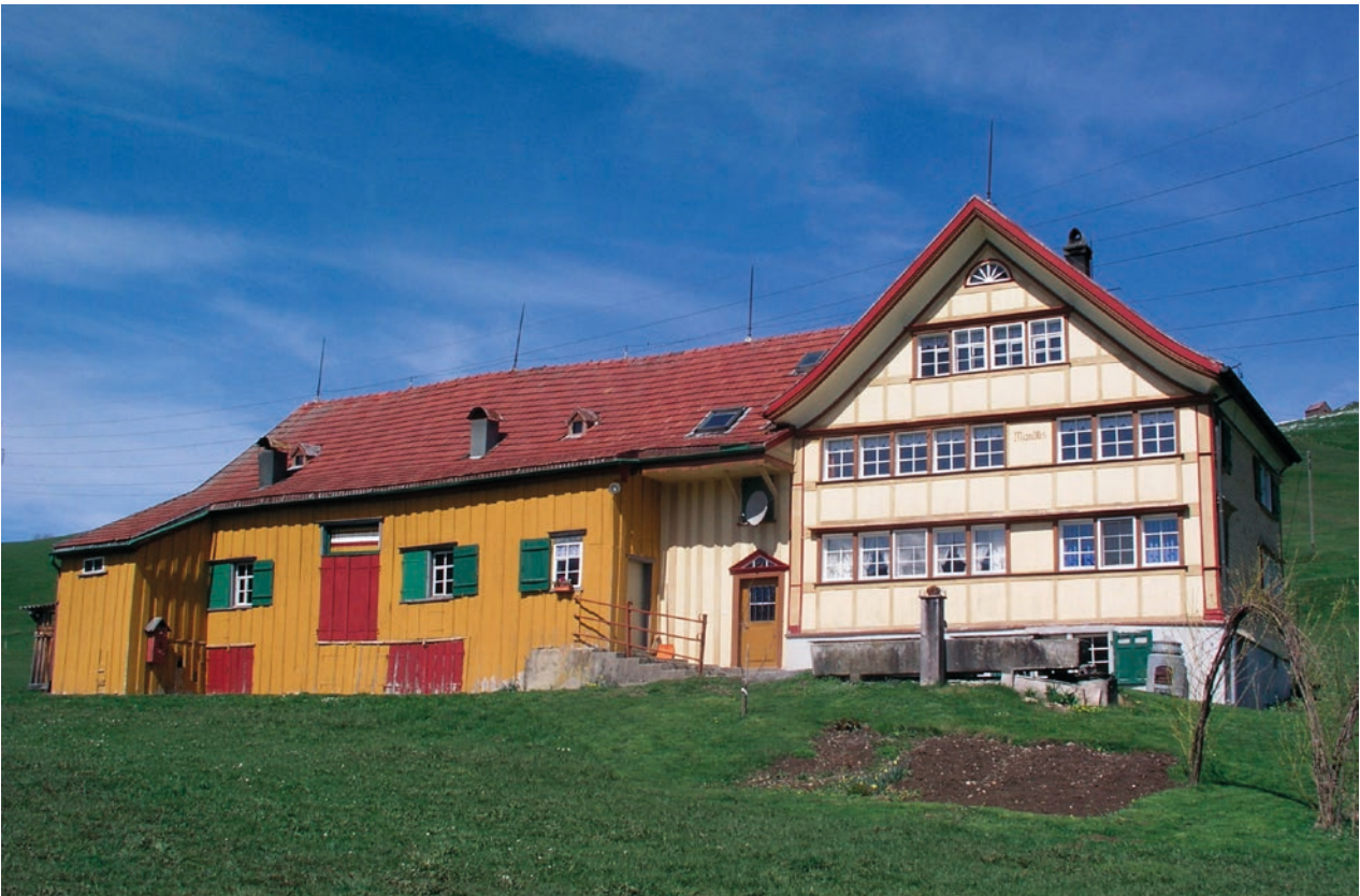
290. Gontenbad, Kanton Appenzell Innerrhoden, Schweiz, Haus und Scheune als Farbakzente in der tiefgrünen Weide
