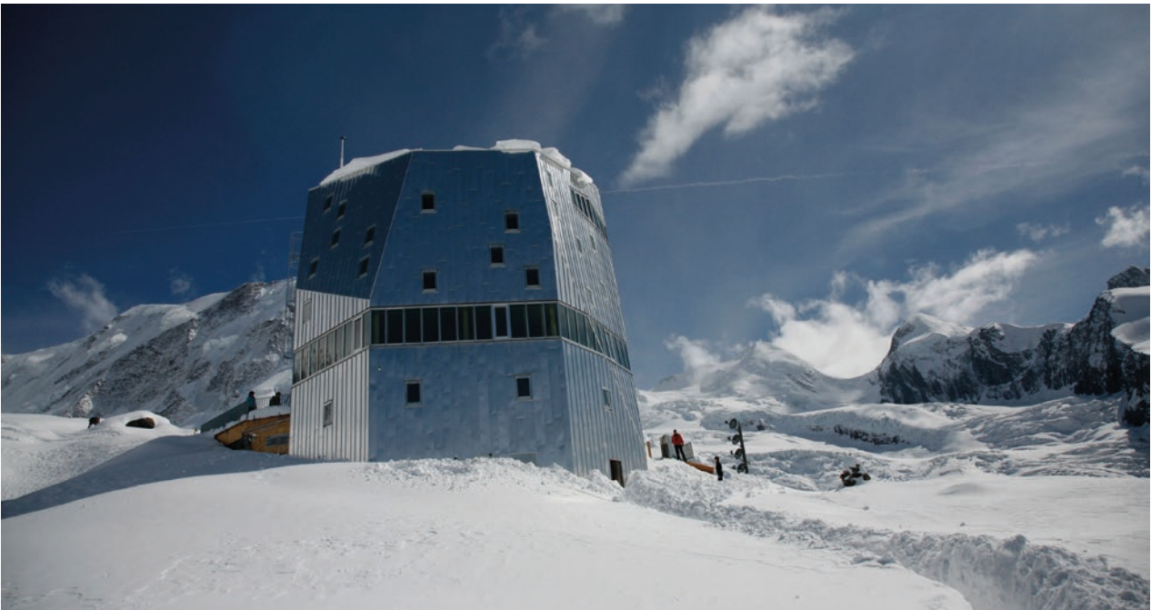
270. Zermatt, Schweiz, Monte Rosa-Hütte, Hütte als High-Tech-Maschine
