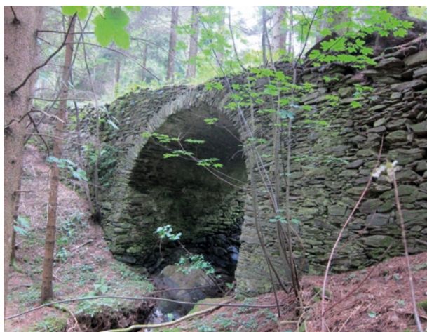
225. Pöggstall, Niederösterreich, Bogenbrücke der Fürnberg'schen Poststraße
