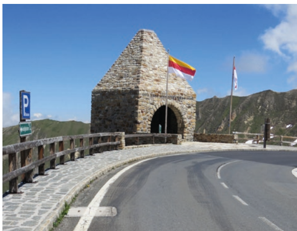
233. Salzburg, Großglockner-Hochalpenstraße, Gedenkzeichen von Clemens Holzmeister am Fuscher Törl von 1935
