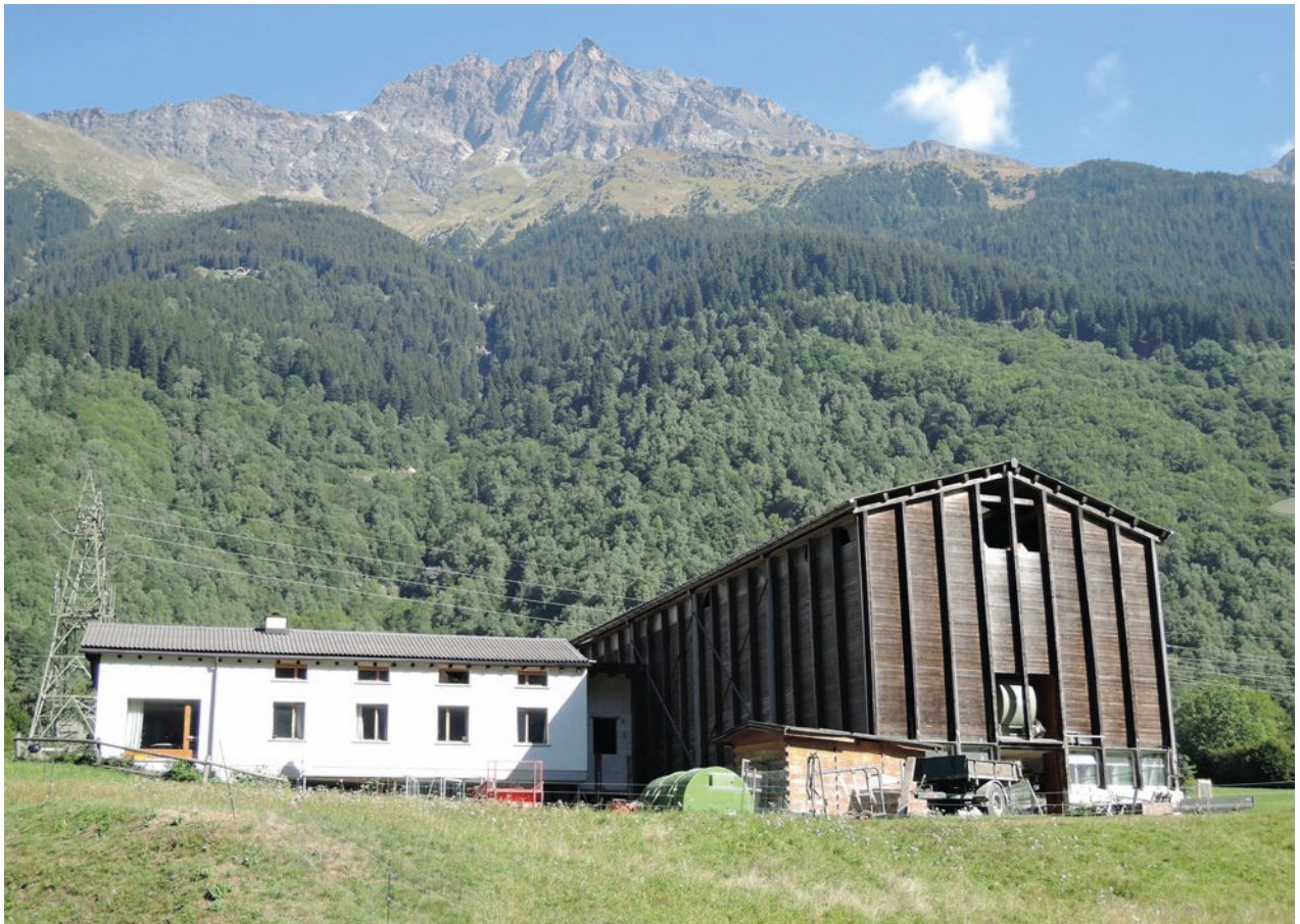
292. Bregaglia, Kanton Graubünden, Schweiz, Landwirtschaftsbauten der Nachkriegsjahre sind geprägt vom Bemühen um Optimierung der Betriebsabläufe, Standardisierung der Bauten und Minimierung der Kosten. Architektur und Einpassung in die Landschaft sind untergeordnete Themen
