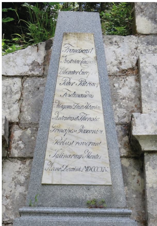
239. Bad Ischl, Oberösterreich, Portal des Maria Ludovika-Stollens, Pylon mit Inschriftentafel
