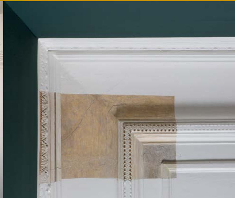
Befundöffnung © Bundesdenkmalamt, Foto: Bettina Neubauer-Pregl
