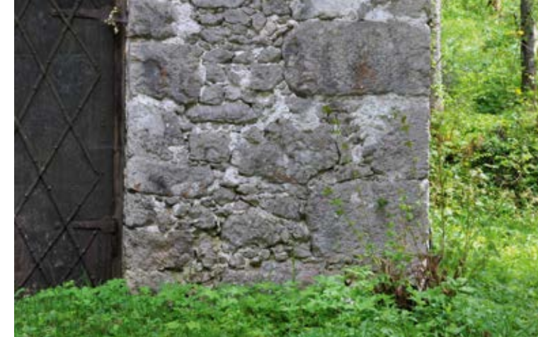
Bruchsteinmauerwerk mit Eckquadern © Friedrich Idam
