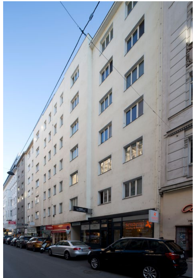
66. Wien 1, Wollzeile 30–32, erbaut 1937/38, aktueller Zustand
