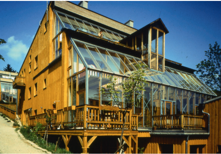
Abb. 5: Purkersdorf, Wohnprojekt Alternatives Wohnen, Georg Reinberg / Jörg Riesenhuber, 1981–1984
