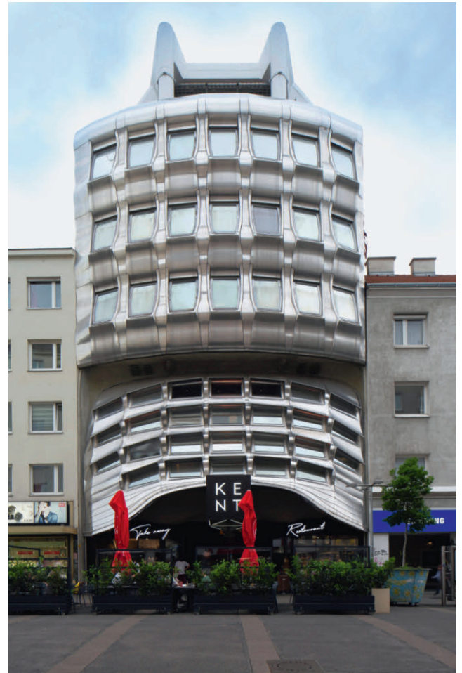
Abb. 10: Wien, ehem. Zentralsparkasse, Favoritenstraße 118, Günther Domenig, 1975–1979
