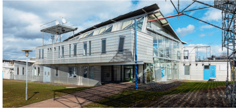
Abb. 3: Stuttgart, Hysolar-Institutsgebäude der Universität Stuttgart, Behnisch und Partner, 1987
