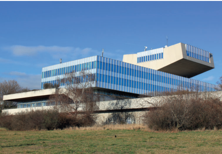
Abb. 11: Wien, ehem. AUA-Gebäude, Fontanastraße 1, Georg Lippert, 1975–1978, 2012/13 Abbruch
