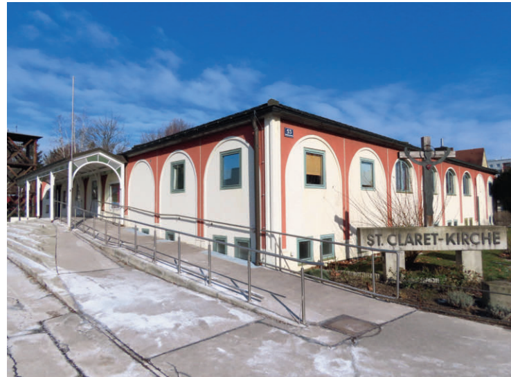
Abb. 8: Pfarrkirche St. Claret-Ziegelhof, Wien, Außenansicht
