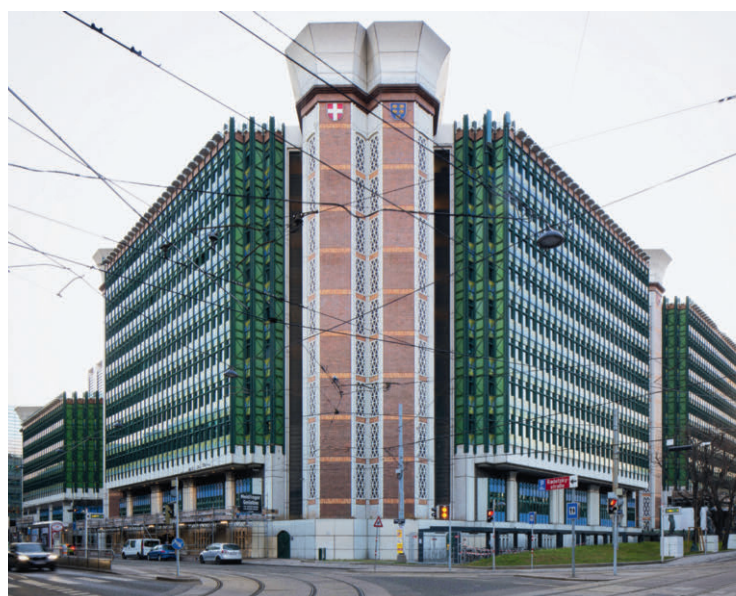
Abb. 1: Bundesamtsgebäude Radetzkystraße 2, Wien, Ansicht von Norden, 2025
