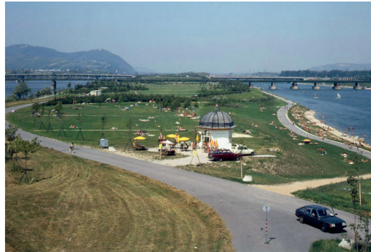
Abb. 12: Donauinsel, Blick von der Brigittenauer Brücke nach Nordwesten, späte 1980er Jahre
