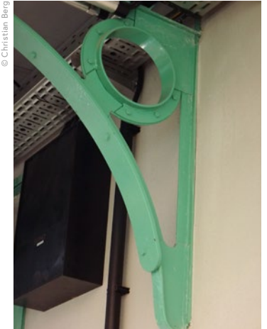
Details der Stahlkonstruktion mit eingeschraubtem Verstärkungselement
