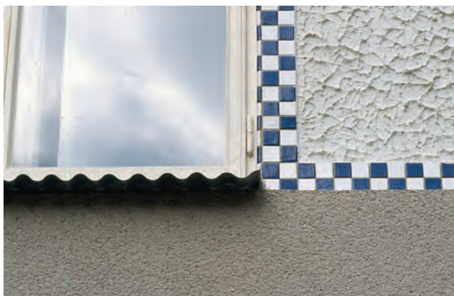
Abb. 5: Sanatorium Purkersdorf, Detail nach Restaurierung, 1996
