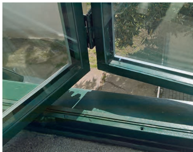
Abb. 6: Kraus-Stahlfenster nach der Restaurierung, Masaryk-Studentenhaus, Brno
