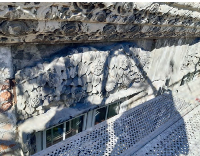
Abb. 3: Villa Ast, Südfassade, Detail im Bereich des Traufgesimses und der reliefierten Fensterrahmen aus Kunststeinguss nach Entfernung des Bewuchses, Herbst 2021
