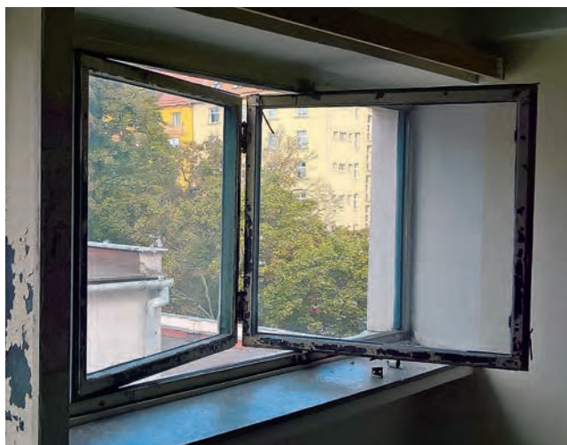
Abb. 5: Kraus-Stahlfenster vor der Restaurierung, Masaryk-Studentenhaus, Brno, Architekt Bohuslav Fuchs, 1930
