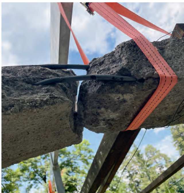
Abb. 14: Eisenbetonpergola während der Restaurierung, 2021
