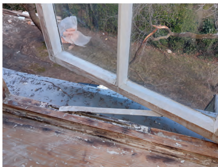
Abb. 5: Villa Bernatzik, im Falz des Fensterrahmens verdeckter Flügelfeststeller während der Sanierungsarbeiten, Frühjahr 2022
