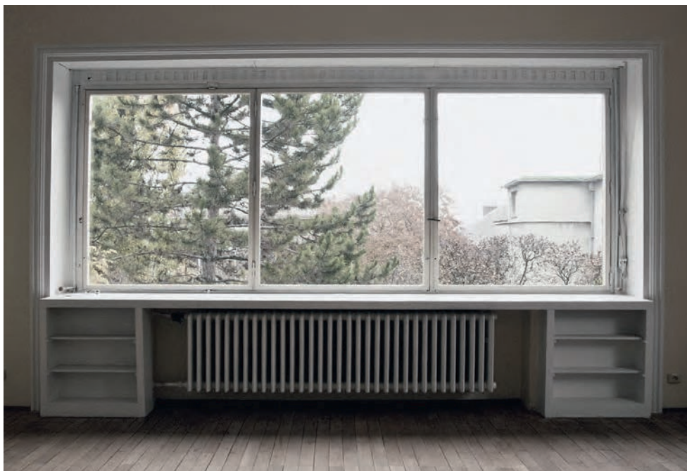
Abb. 7: Kraus-Stahlfenster, Villa Lengye, Bratislava, aktueller Zustand
