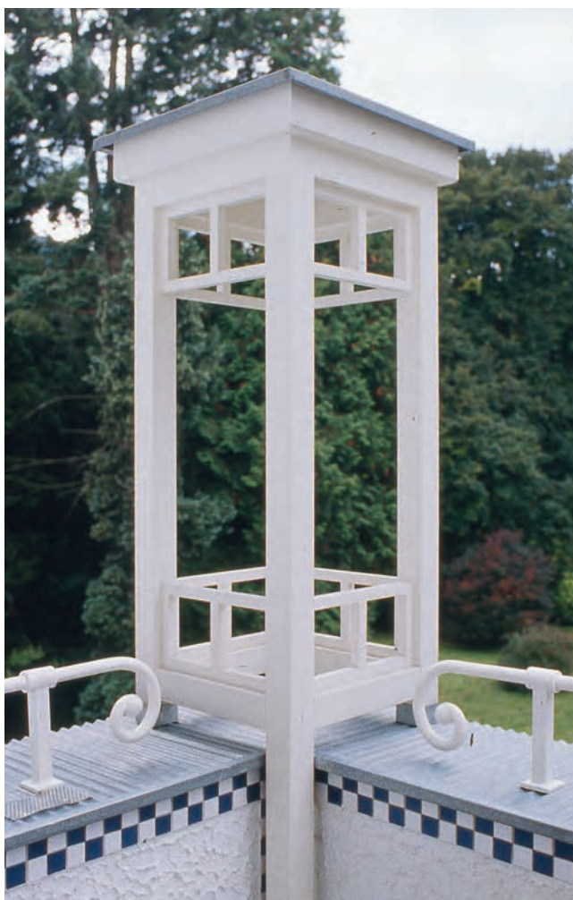
Abb. 6: Sanatorium Purkersdorf, Detail nach Restaurierung, 1996
