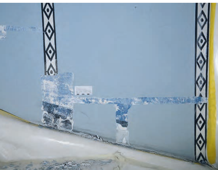
Abb. 7: Villenkolonie Kaasgraben, Detailfoto der restauratorischen Befundung der Wände des Stiegenhauses
