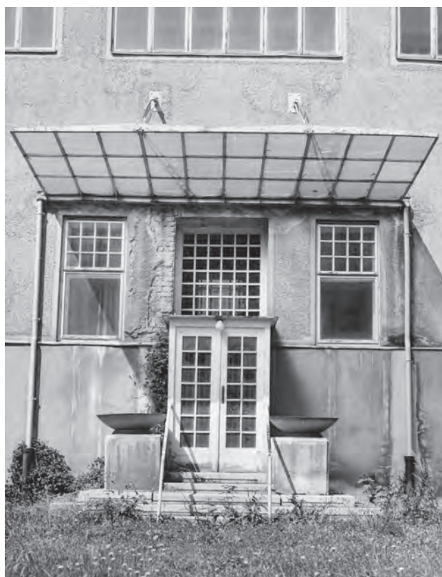
Abb. 3: Sanatorium Purkersdorf, Eingang vor Restaurierung, 1986
