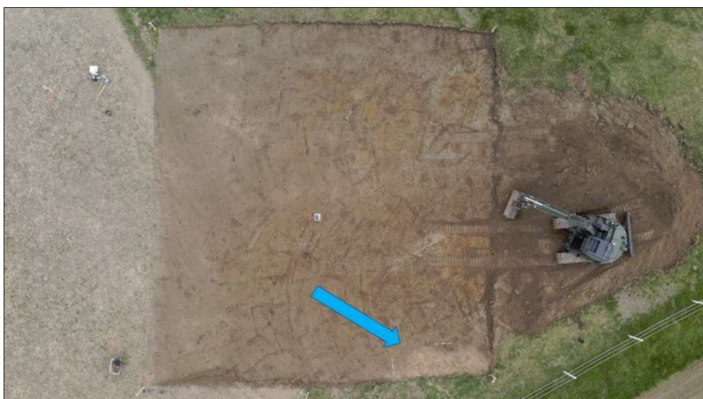
Abb. 34: Oberbodenabtrag auf VF 03 mit der markierten hellen Bodenverfärbung in der südöstlichen Ecke.
