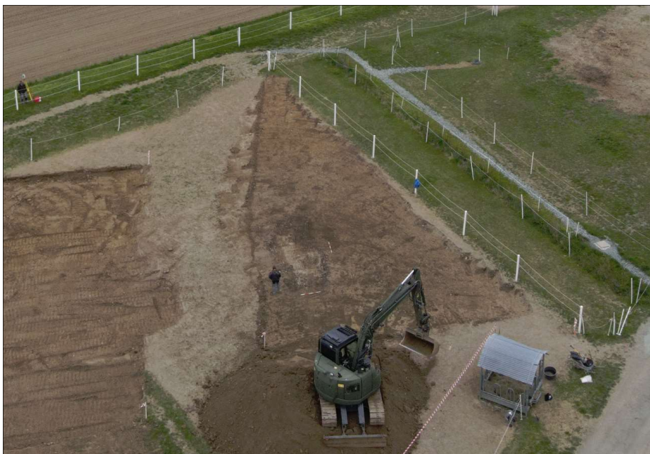
Abb. 25: Oberbodenabtrag auf VF 02.
