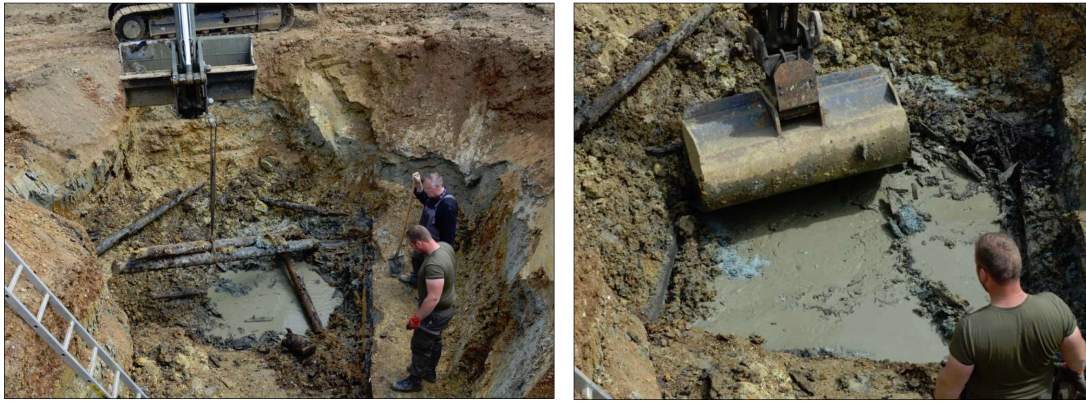
Abb. 30 und 31: Entnahme der Holzpfosten und vollständige Verfüllungsentnahme bei Obj. 03.
