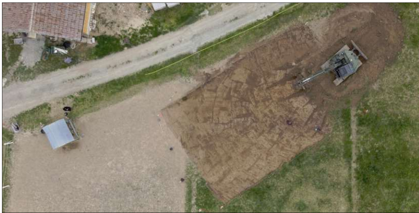
Abb. 23: Oberbodenabtrag auf VF 01.
