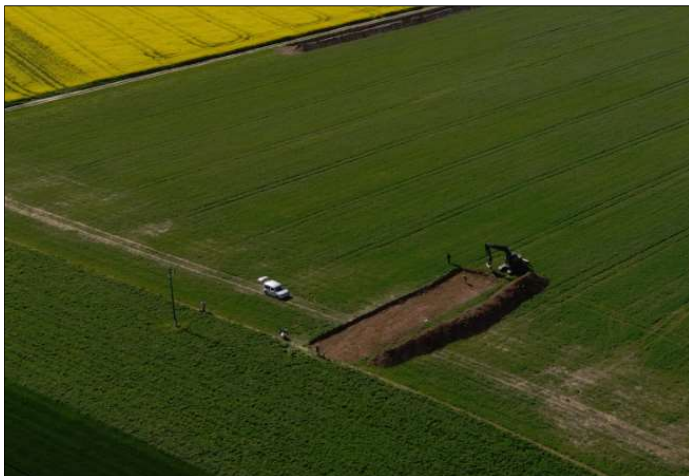
Abb. 48: VF 09 auf Gst. 11840 während des Oberbodenabtrags.
