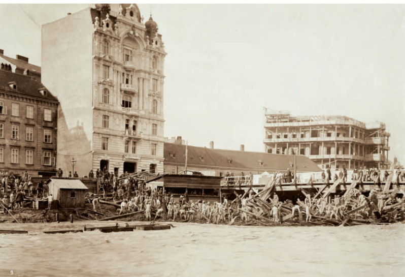
Abb. 1: Kettenbrücke über Wienfluss bei Hochwasser, Wien, 1897
