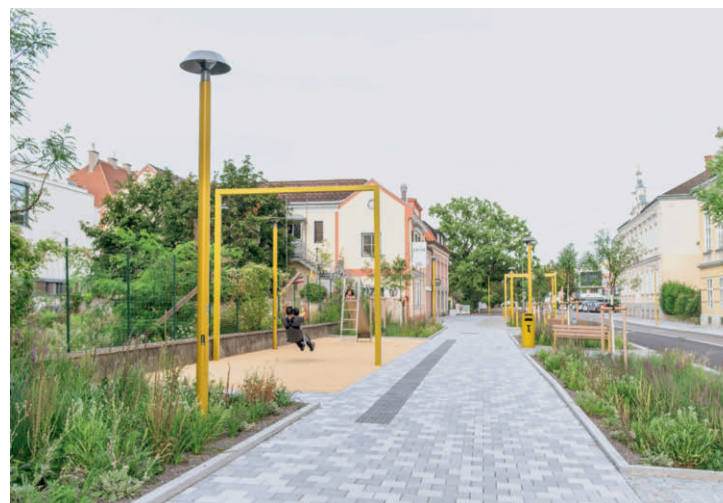
Abb. 4: Der Promenadenring wurde durch Querschnittsänderung und Gestaltung vom Verkehrsraum zum vielseitigen Stadtraum, St. Pölten
