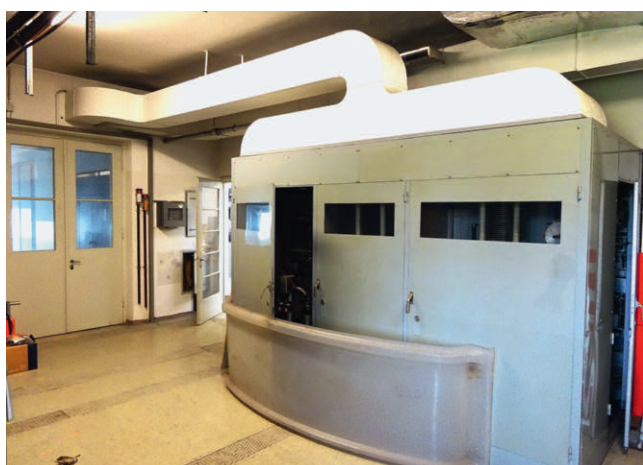
Abb. 10: Oben am Sender die mächtigen Abluftkanäle
