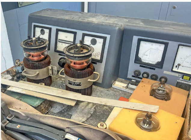
Abb. 7: Senderüberwachungspult, links zwei Reseveröhren BTL 6-1, rechts zwei Röhren Q400 in Schaumgummi gelagert
