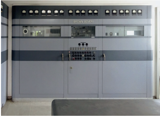
Abb. 2: 25-kW-Sender von BBC, „Sender 1“, in Betrieb ab 1955
