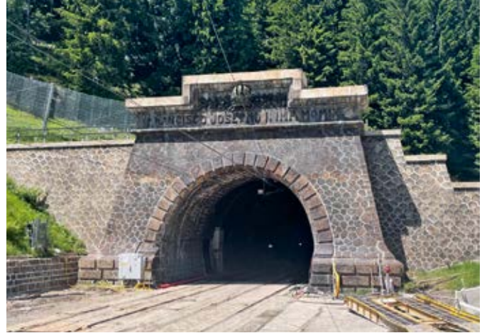
Südportal des Tauerntunnels in Mallnitz, restaurierter Zustand © Zottmann Restaurierwerkstatt GmbH
