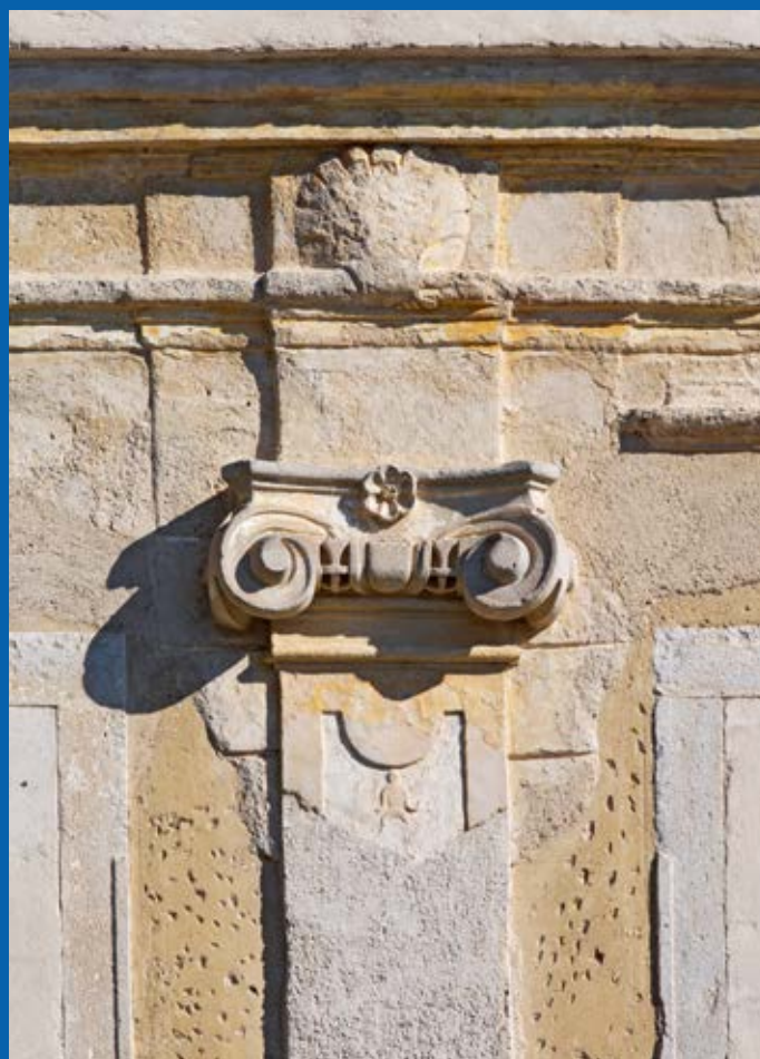
Detail der konservierten Straßenfassade, 2025 © Bundesdenkmalamt, Foto: Bettina Neubauer-Pregl
