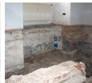
westlichstes Fensterparapet d. Südwand
