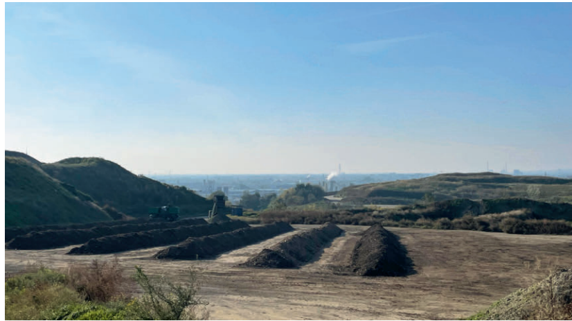
Abb. 6: Deponie Langes Feld, Herstellung Vererdungsmaterial, 2024
