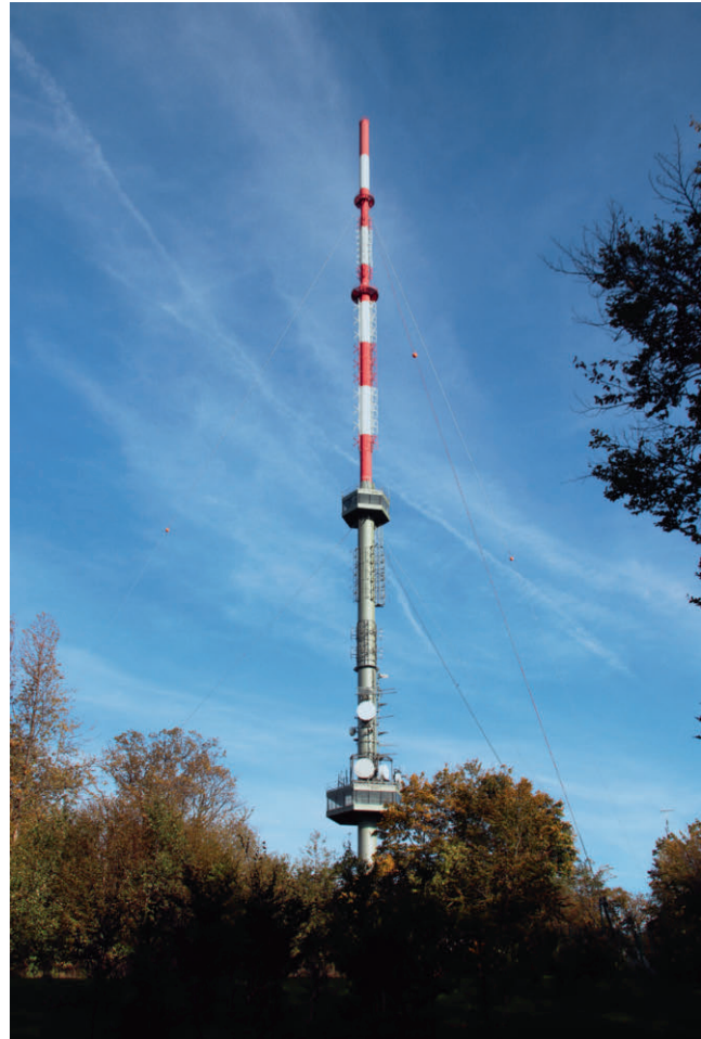
Abb. 6: Sendemast mit verglasten Richtfunkbühnen, rot-weißer Mastmarkierung und mehrfacher Abspannung, 2024
