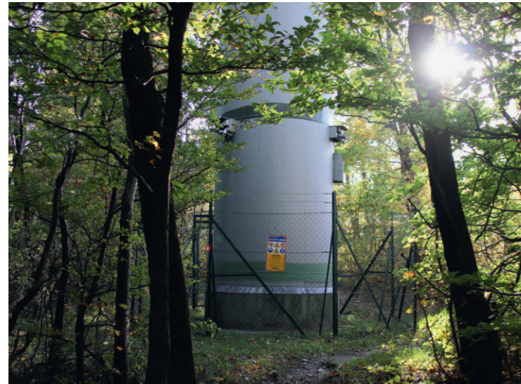
Abb. 8: Eingezäunter Mastfuß mit grünem Maschendrahtzaun, geringe bauliche Inanspruchnahme der Gipfelfläche, 2024
