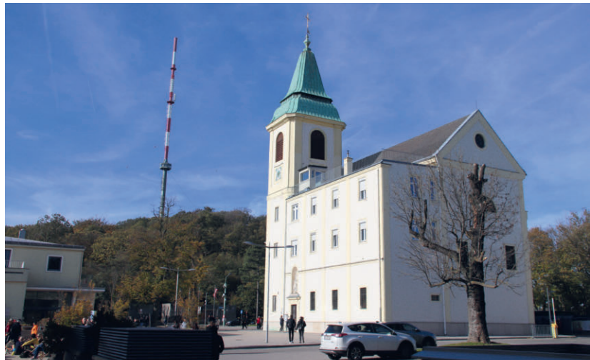
Abb. 4: Sendemast der Anlage WIEN1 mit Kirche St. Josef im freizeitgeprägten Umfeld am Kahlenberg, 2024
