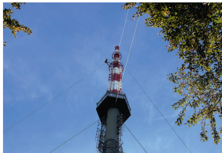
Abb. 2: Sendeanlage WIEN1, Sendemast mit Antennenzylinder am Gipfel des Kahlenbergs, 2024
