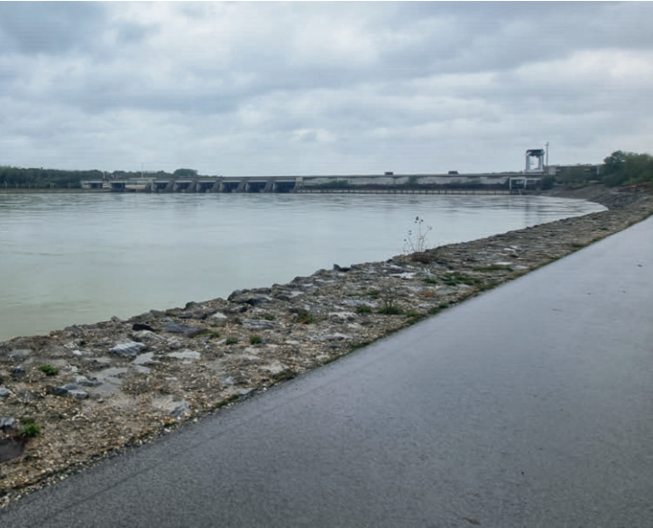
Abb. 2: Laufkraftwerk Greifenstein, Blick vom Donauufer Richtung Westen, 2024
