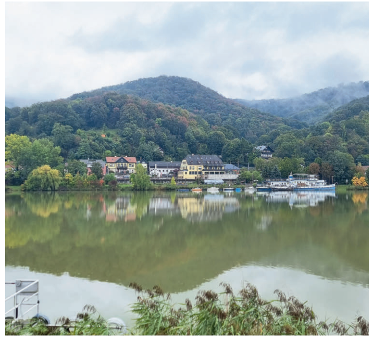
Abb. 7: Laufkraftwerk Greifenstein, Blick nach Süden über den Donau-Altarm, 2024
