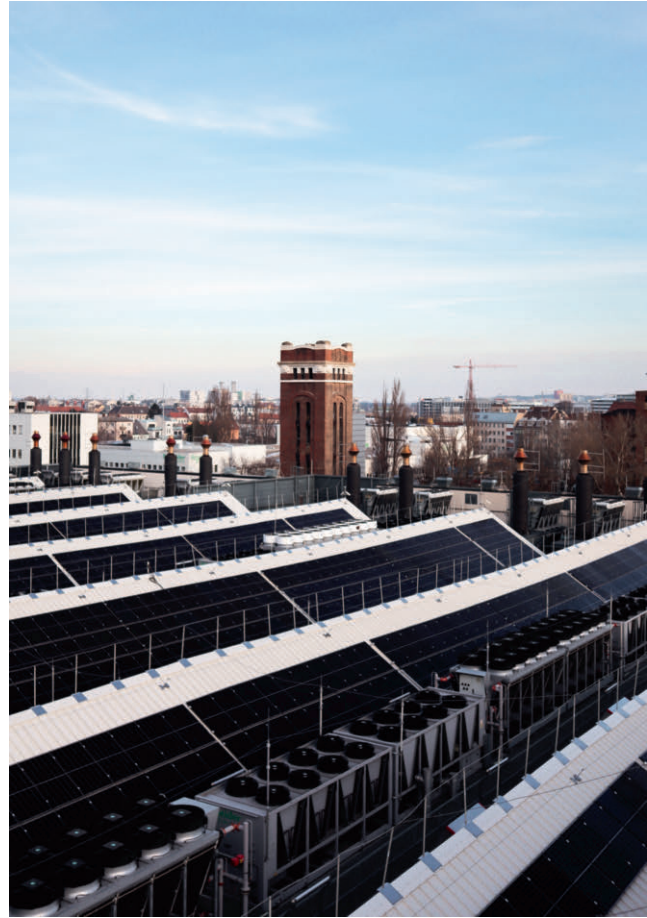
Abb. 6: Dachlandschaft mit Gebäudetechnik, Blick gen Ost auf ehemaligen Wasserturm, 2024
