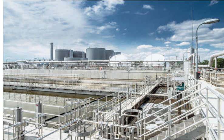
Abb. 5: Hauptkläranlage Wien-Simmering, Rohrfeld und Faultürme Panorama, o. J.
