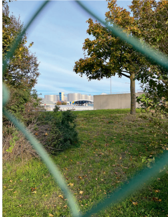
Abb. 3: Hauptkläranlage Wien-Simmering, Faultürme in der Ferne, 2024
