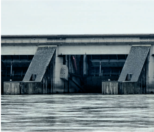
Abb. 3: Laufkraftwerk Greifenstein, Blick auf eines der sechs Wehrfelder, 2024
