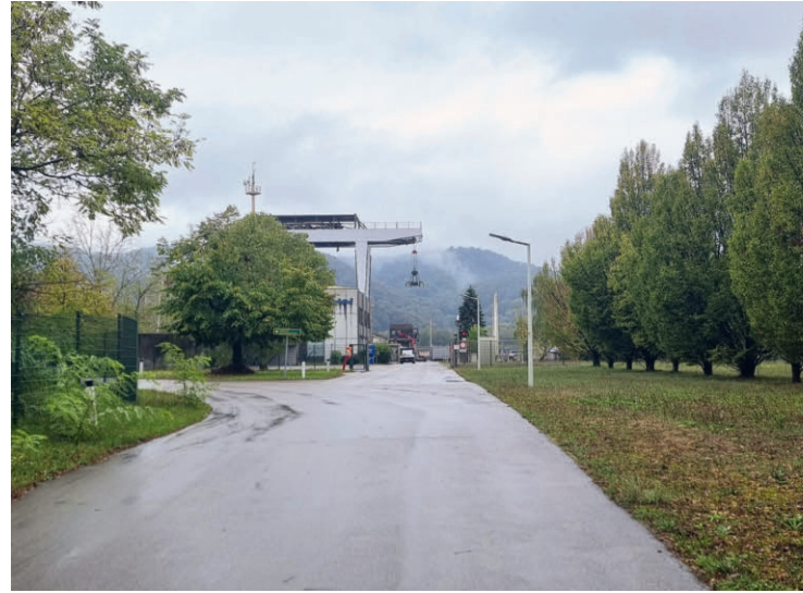
Abb. 4: Laufkraftwerk Greifenstein, Blick nach Süden auf den Portalkran, 2024
