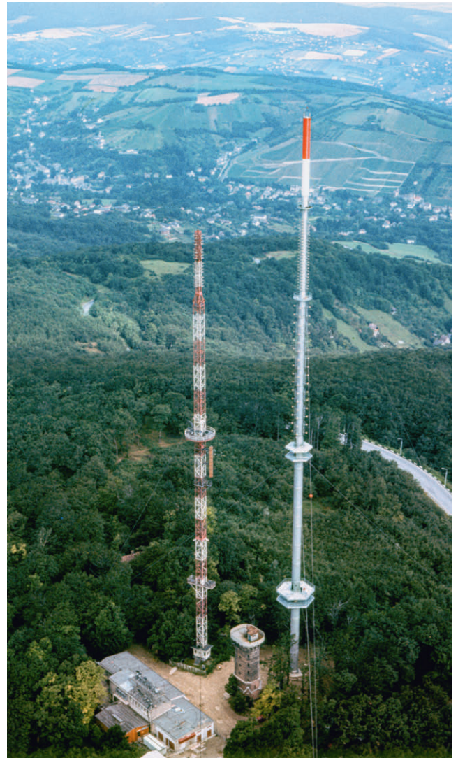
Abb. 5: Sendeanlage WIEN1 am Kahlenberg mit Fachwerkurm von 1956 (links) und Stahlrohrmast von 1974 (rechts), dazwischen die Stefaniewarte
