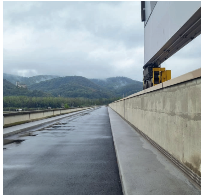
Abb. 6: Laufkraftwerk Greifenstein, Blick nach Süden über die Kraftwerksbrücke, 2024
