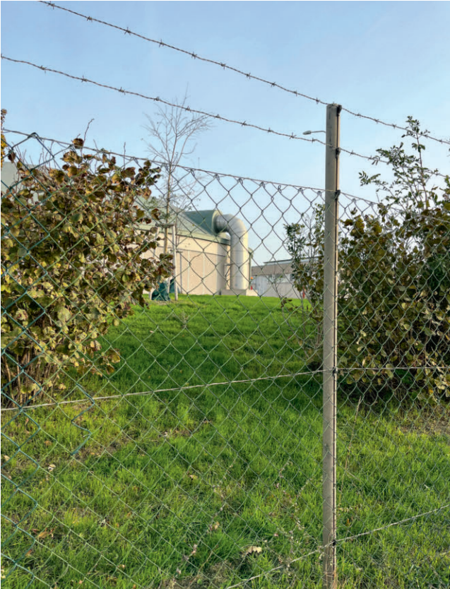
Abb. 2: Hauptkläranlage Wien-Simmering, Klärgebäude hinter Stacheldrahtzaun und Bewuchs, 2024
