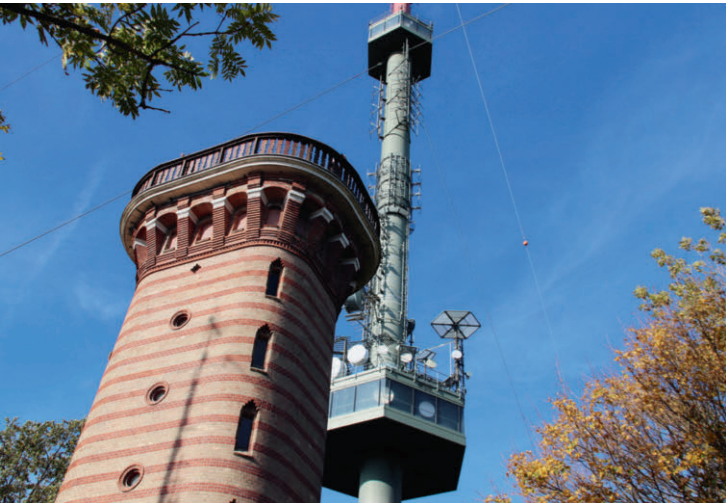
Abb. 9: Sendemast im Kontrast zur Stefaniewarte, Gegenüberstellung historischer und technischer Infrastruktur am Kahlenberg, 2024
